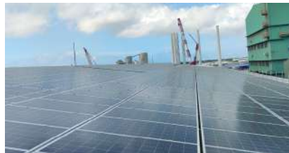
建新國際10號倉 / Chien Shing Harbour Service Co., Ltd.
