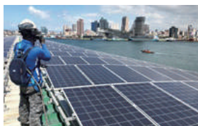
檢查模組 Inspection of Solar Module
